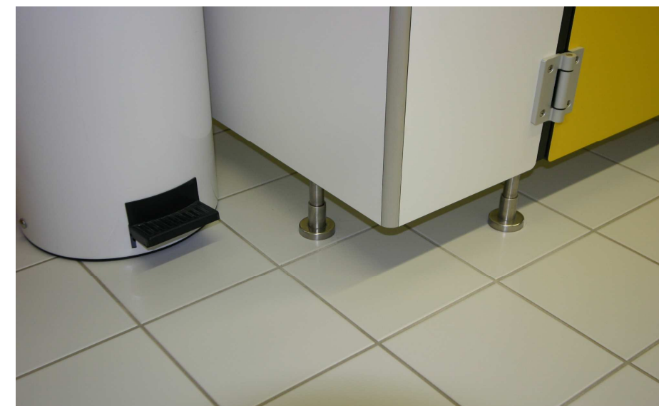
Verbindung der Vorder- wand mit Eckwand durch Aluminiumrund- eckprofil Radius 13mm Unfallsicherheit
