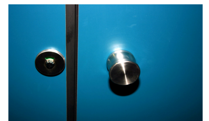
Aussenansicht Knopf, Verriegelung und Türanschlagprofil
