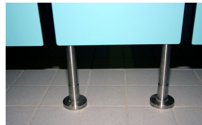
Aussenansicht Füße, Türanschlagprofil und Unfallschutzradius von 5mm
