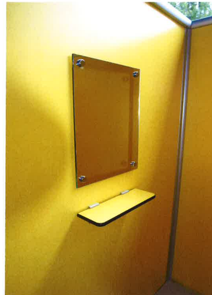
Innenansicht mit Spiegel und Ablage aus 13mm HPL.
