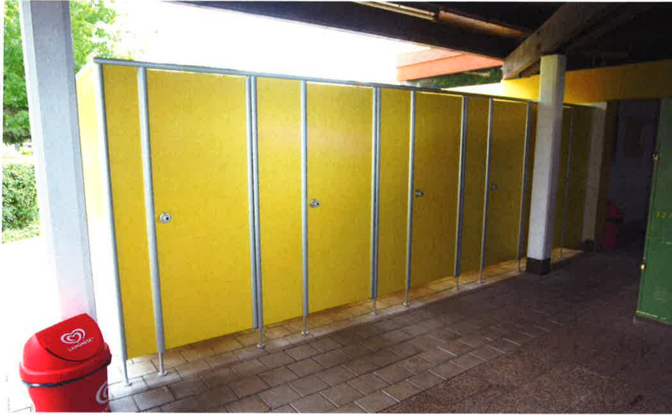
13mm HPL-Anlage mit Aluminium-Rundpfosten als Türanschlagprofil. Bandseite als Drehzapfenband mit Fingerklemmschutz ausgeführt. Die Aluminium-Rundpfosten sind stabil mit der Kopfschiene durch M 10x50 mm (DIN 6912) verbunden. Füße aus Alu.
